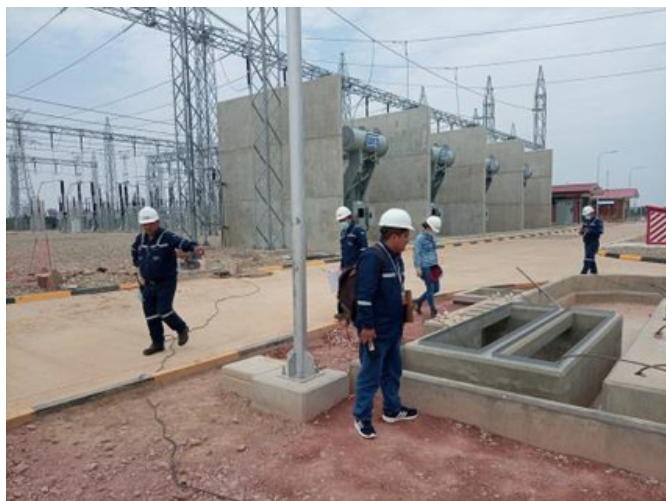
Inspección a obras civiles
