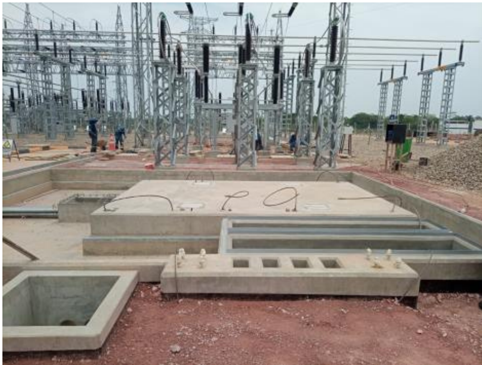
Fundaciones transformador 115/24.9 kV
